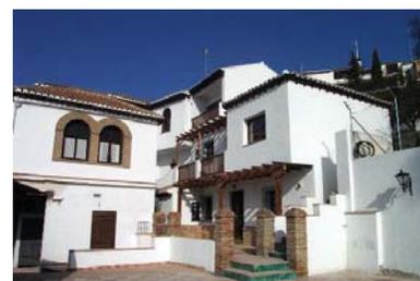
**Casas encaladas:** el dióxido de carbono atmosférico reacciona con el hidróxido de calcio formando una capa blanca de carbonato de calcio.
